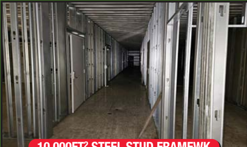
10,000FT 2 STEEL STUD FRAMEWK
