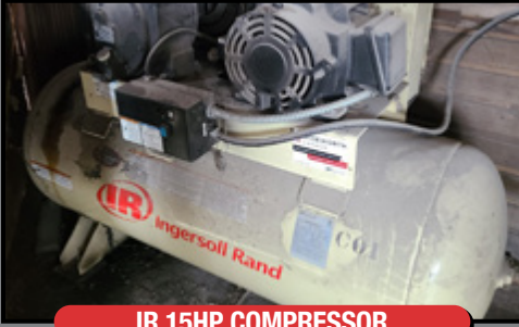
IR 15HP COMPRESSOR
